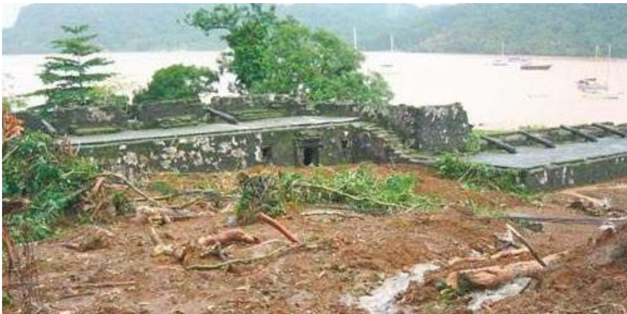
Figura 1. Fuerte de Santiago afectado por los deslizamientos, Portobelo. Fuente: Periódico El Panamá América, publicada el 23 sept. 2011
